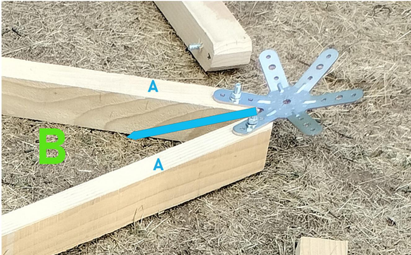
Montieren Sie also an jedem der 5 6A-Verbinder 2 A-Säulen (groß / blau) auf beiden Seiten des Buchstabens B. Die beiden A-Säulen sind mit dem Buchstaben B gekennzeichnet.
