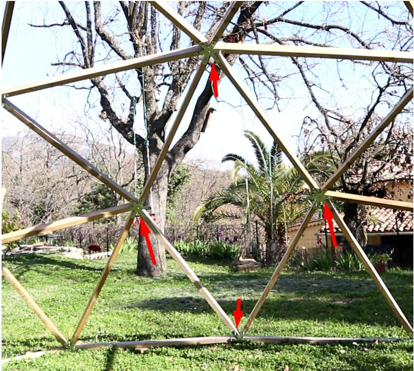
Ich empfehle Ihnen in diesem Fall, die Struktur zu verstärken, indem Sie Holzschrauben in jedes freie Loch der 4 Verbindungen um Ihre neue Öffnung herum einfügen.
