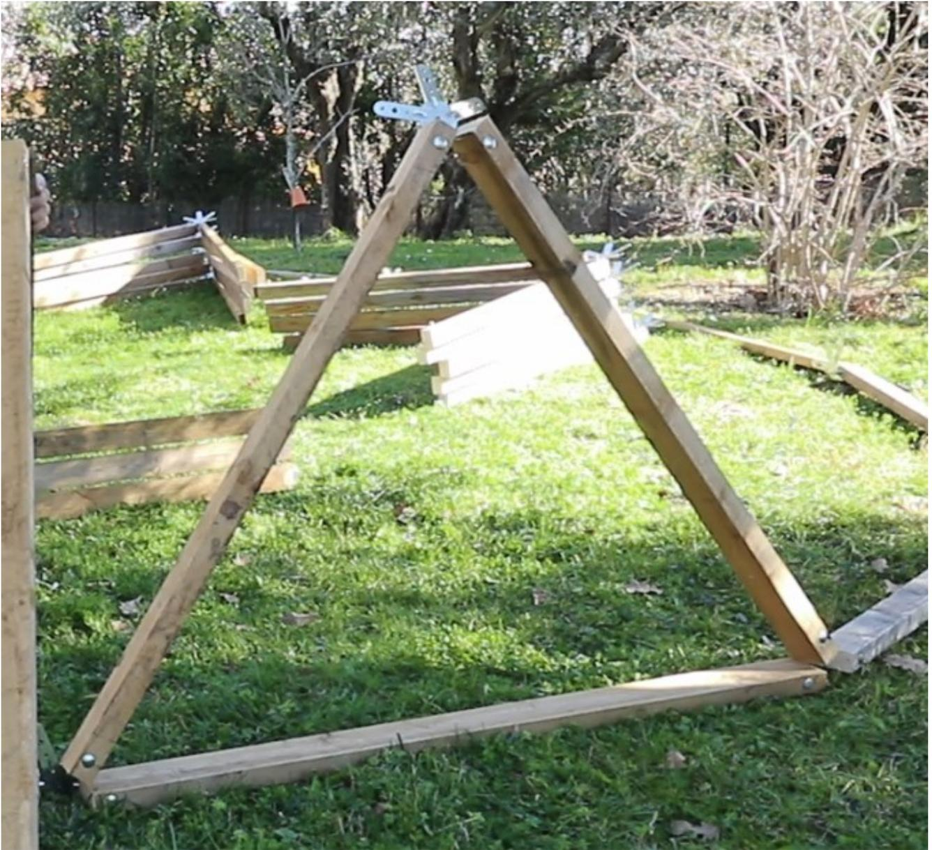
WICHTIG: Ich empfehle Ihnen, diese Dreiecke zu stützen, solange der Gurt noch nicht installiert ist. Verwenden Sie temporäre Stützen, um diese Dreiecke zu stützen.
