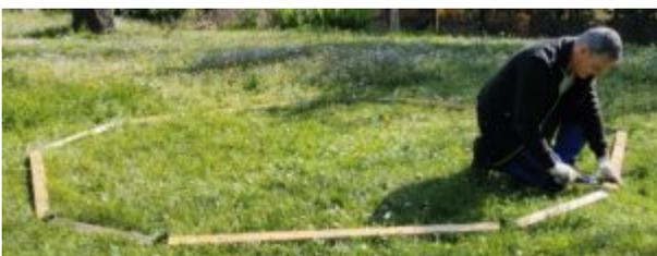
Schrauben Sie alle Pfosten der Basis an, vergessen Sie nicht, Holzschrauben in die freien Löcher zu stecken:
