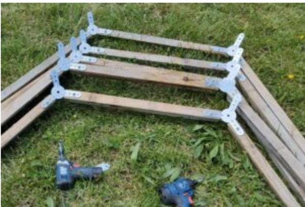
Und schrauben Sie diese Sets von 3 Pfosten an die Basis, wo sich die großen Pfosten befinden:
