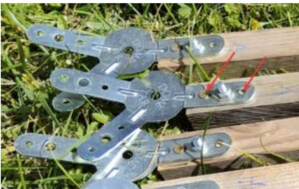
Legen Sie die 5 Pfosten mit den angeschraubten Verbindern in einem Kreis aus, wobei Sie zwischen jeden Pfosten einen großen Pfosten legen:
