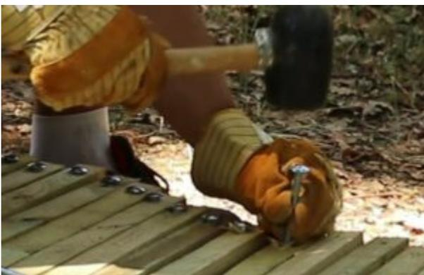
**Tipp:** Wenn der Hammer nicht ausreicht, kannst du auch Schrauben und Unterlegscheiben verwenden und die Schraube so fest anziehen, dass sie gut in das Holz eindringt.
