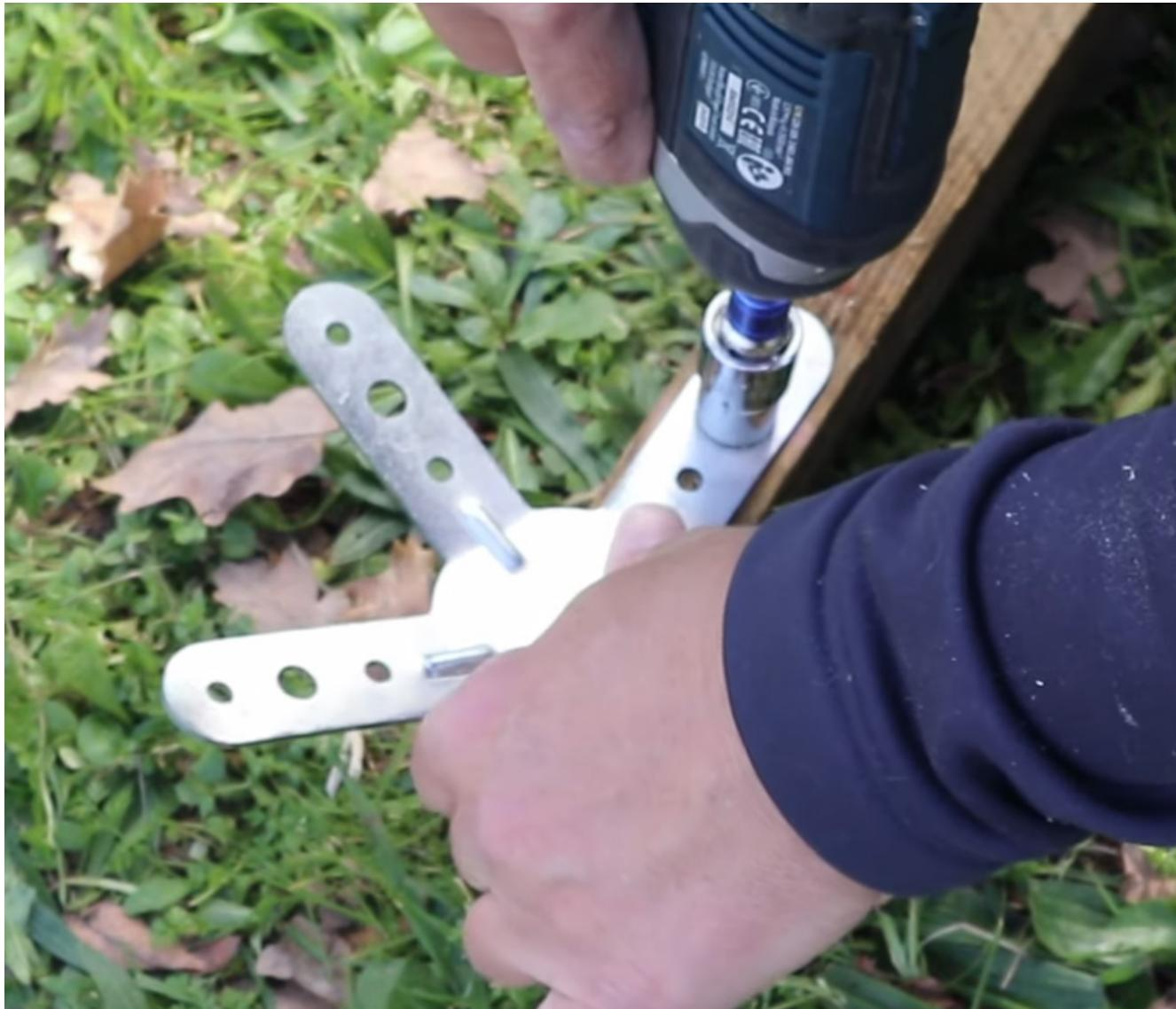
Ich schraube diesen Pfosten auf die Kuppel. Er muss so lange gestützt werden, bis die anderen Anschlüsse installiert sind.
