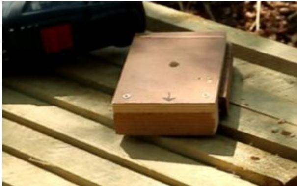
Fertigen Sie nun die Löcher in den Pfosten an, indem Sie Ihr Muster verwenden und versuchen, so gerade wie möglich zu bohren.
