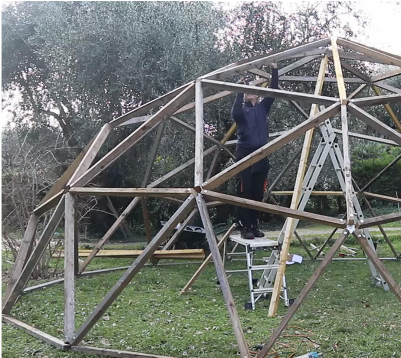
Ich installiere, indem ich die 4 fehlenden Anschlüsse anschraube.
