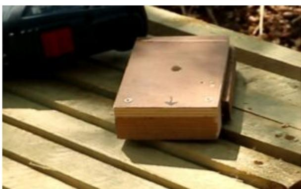
Maintenant terminez les trous dans les montants en utilisant votre patron et en essayant de percer aussi droit au possible.
