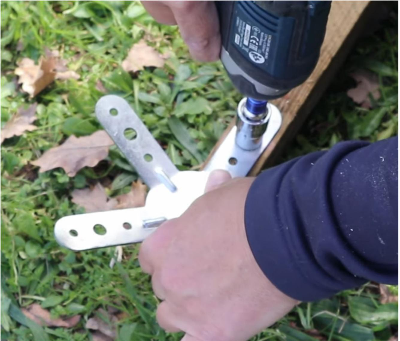
Je visse ce montant sur le dôme. Il faut le soutenir le temps d'installer les autres connecteurs.
