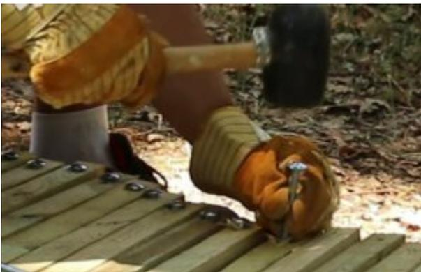
**Astuce:** si le marteau n'est pas suffisant vous pouvez utiliser vis et rondelle et serrer le boulon pour qu'il entre bien dans le bois.
