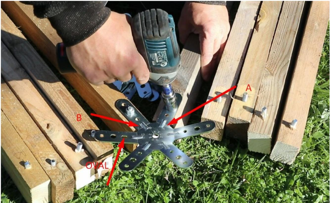
Para los 5 primeros triángulos, tiene que colocar los montantes B a su derecha y los A a su izquierda.
