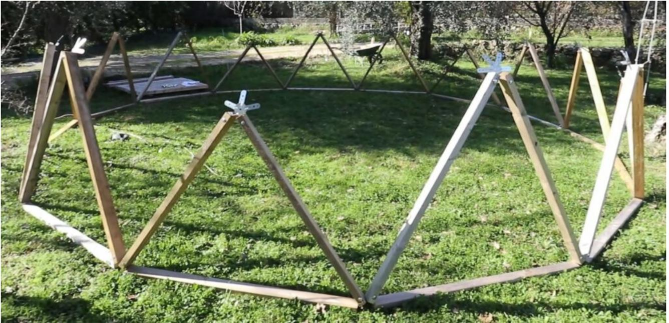
Una vez más, es importante sujetar estos triángulos hasta que se monte el cinturón utilizando otros montantes provisionales:
