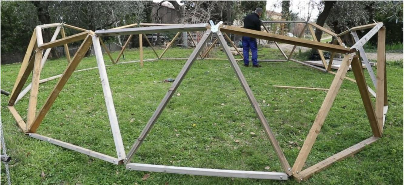
Una vez colocado el cinturón, puede retirar los soportes provisionales que colocó al final de la etapa 2.
