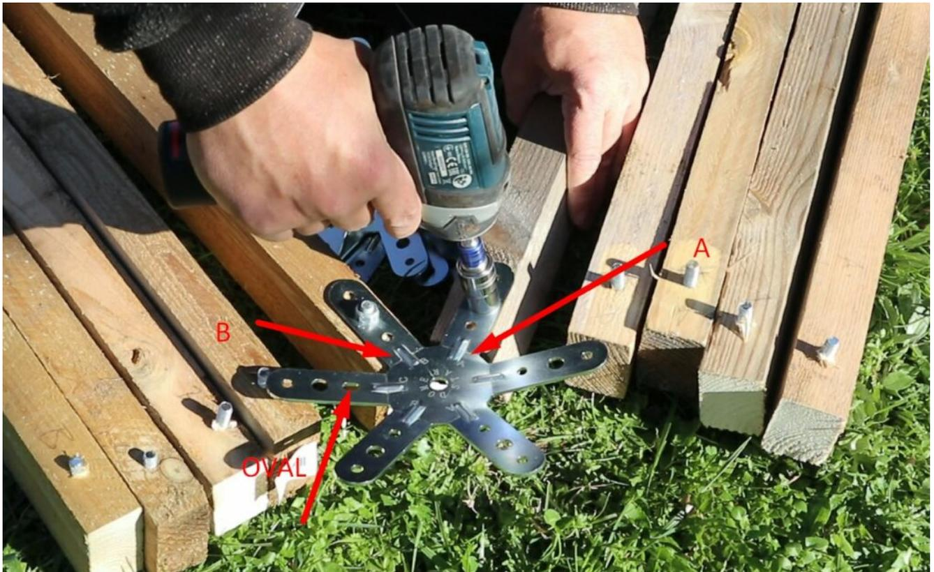
Para los 5 primeros triángulos, coloque los pilares B a su derecha y los pilares A a su izquierda.
