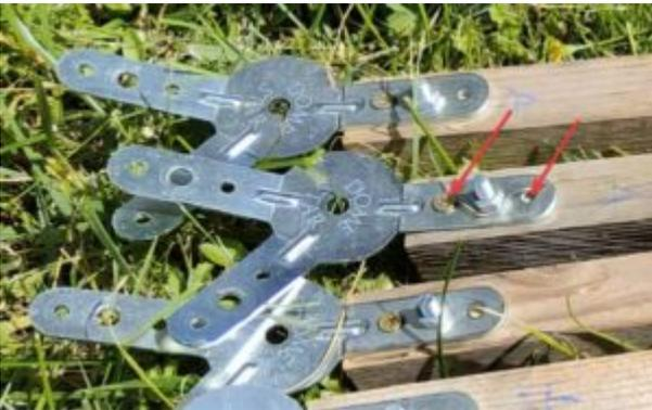
Coloque estos 5 montantes en círculo con los conectores atornillados encima, insertando un montante grande entre cada uno de ellos:
