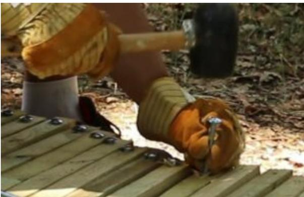
**Consejo:** si el martillo no es suficiente, puede utilizar un tornillo y una arandela y apretar el perno para que penetre en la madera.
