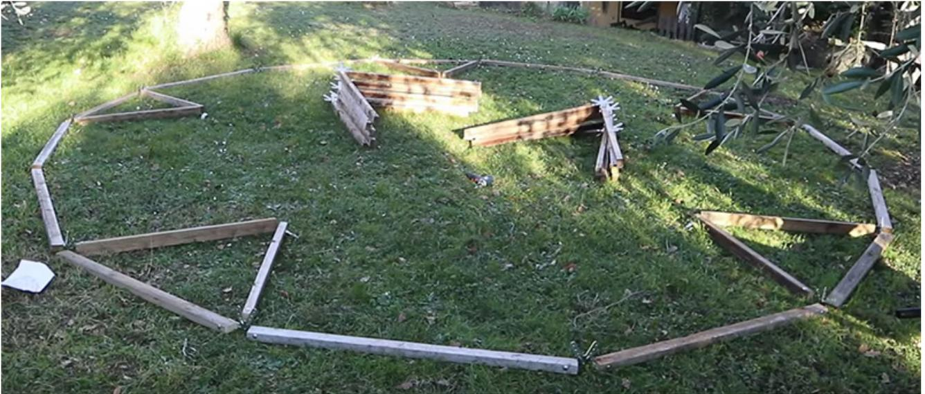
Coloque los otros triángulos en el suelo, asegurándose de que los montantes coinciden con las letras correctas: tómese su tiempo para comprobar que todo está bien!
