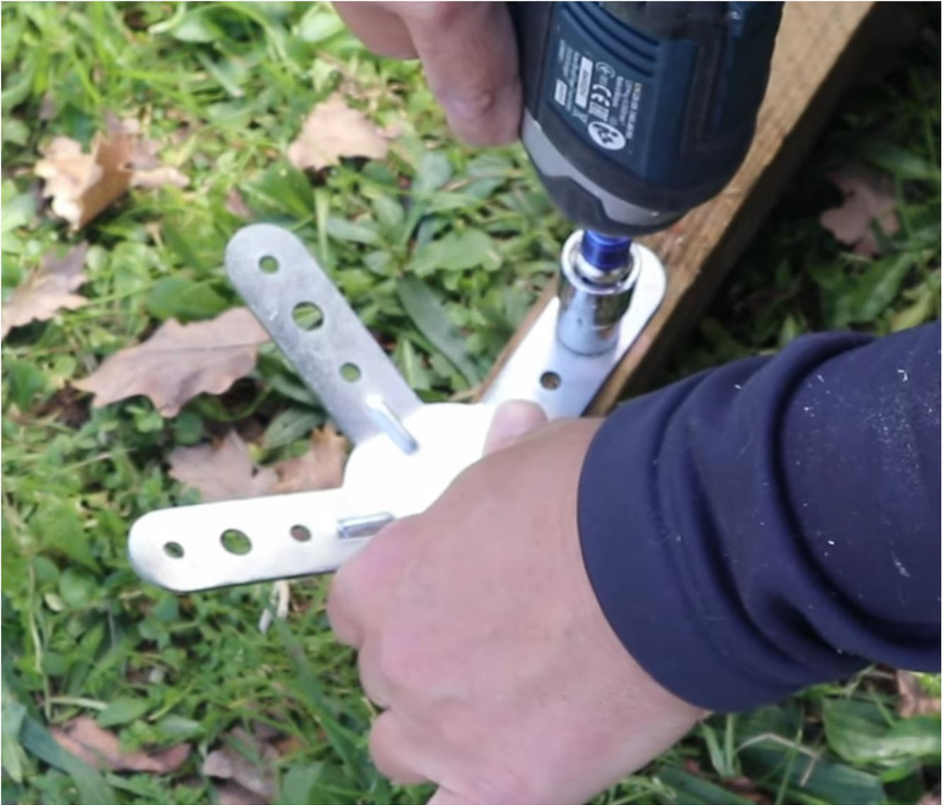
Atornillo este montante a la cúpula. Necesita apoyarse mientras se instalan los demás conectores.
