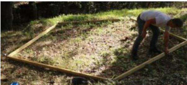
Pensate attentamente all'orientamento della vostra cupola geodetica: dove volete i punti e dove volete i bordi dritti? Ora assemblate i 5 montanti utilizzando ogni volta la gamba esterna libera.
