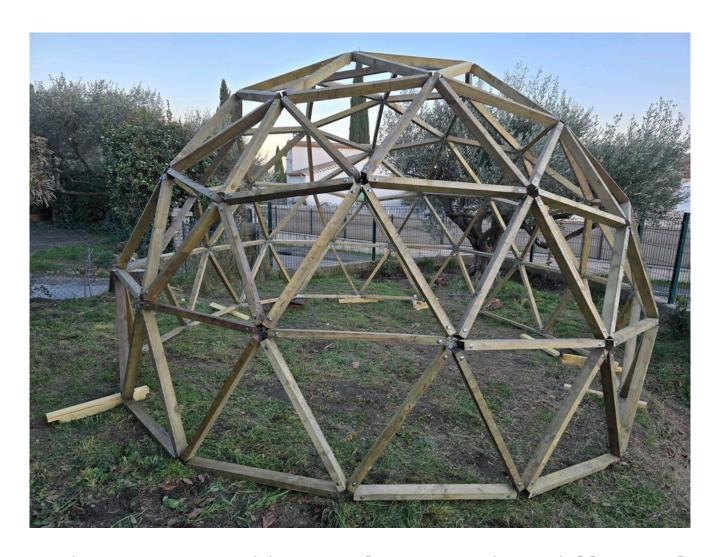
Non ho ancora un video per la costruzione della cupola geodetica 3V 5/8, ma <u>può vedere il video per la costruzione</u> della cupola 3V 3/8. Tuttavia, in questo vecchio video ho montato tutti i triangoli di un pavimento prima di mettere la cintura di questo pavimento: NON raccomando questo modo di fare le cose. Raccomando di mettere la cintura quando i triangoli sono assemblati.
