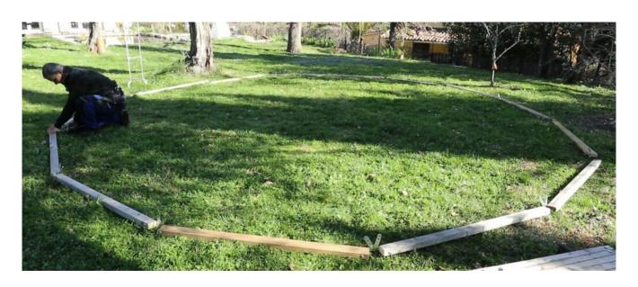
Una volta assemblata la base, può controllare approssimativamente le lunghezze di alcune diagonali per assicurarsi di non aver creato un ovale. Non è necessario essere precisi al centimetro, ma se ha una differenza di 1 metro nelle diagonali, farà fatica in seguito! Tutto si regola da solo durante l'assemblaggio, ma con diversi gradi di sforzo!
